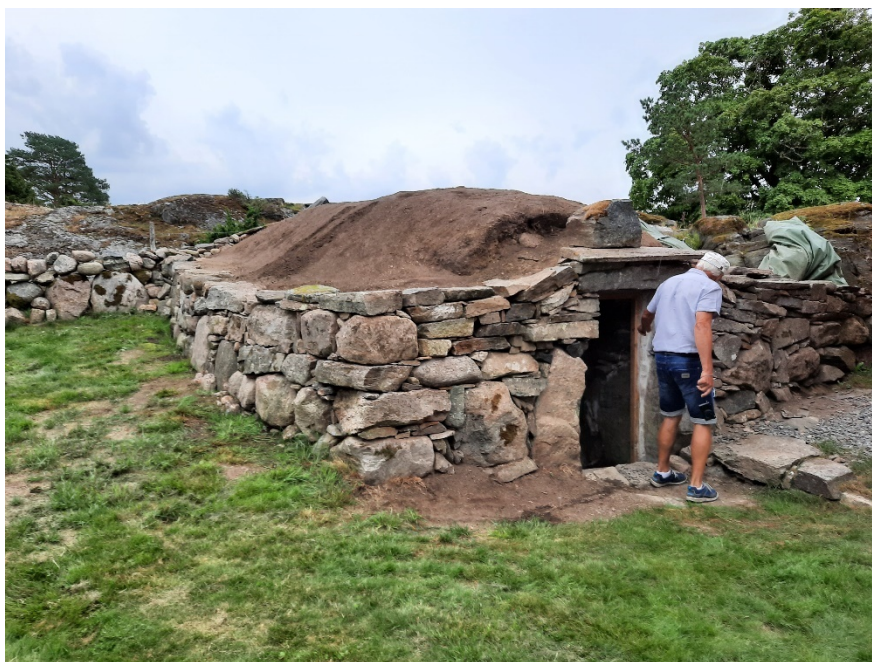
Figur 11: Jordkällarsafari i Kungälv 2020. Byggmetoder studerades på nästan färdigställd jordkällare. Foto Karin Persson, Länsstyrelsen
