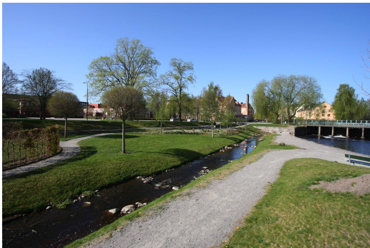
Omlöp för vandrande fisk. Svartån i Örebro.
