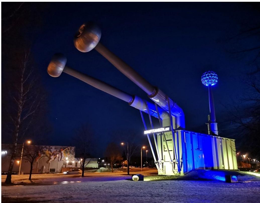
Figur 4: Transformatorhöljet till krafttanken i Ludvika. Bild med tillåtelse från Samarkand2015.
