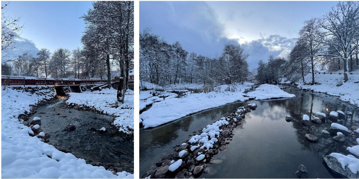
Figur 1. Nedströms och uppströms Husby kvarn i Vagnhärad. Husby kvarn är ett av tre vandringshinder i Trosaån som Trosa kommun åtgärdat under 2022. Husby kvarn har fått en ny sluttande botten täckt av block och natursten. En fåra gör att vattnet koncentreras till passagen vilket gör att den kommer kunna användas vid såväl hög och lågvatten. Foto: Johanna Bergman.
