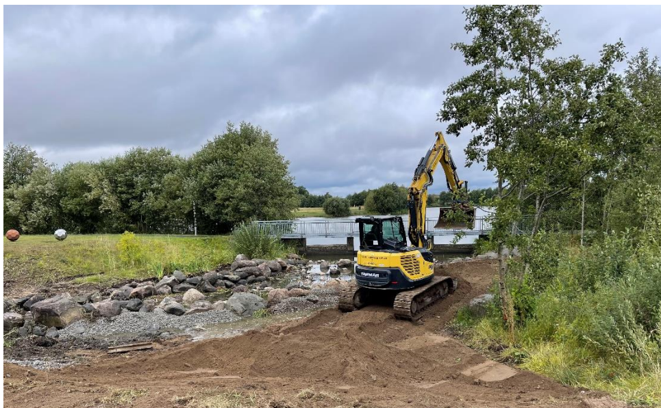
Bild 1. Pågående biotopvård i Svalövsbäcken nedströms Svalövssjön, 2022-09-09. Syftet är att skapa en mer naturlig fåra med förbättrad flödesutjämning, genom att bland annat höja botten och tillföra block, sten och grus. Foto: Marie Eriksson.
