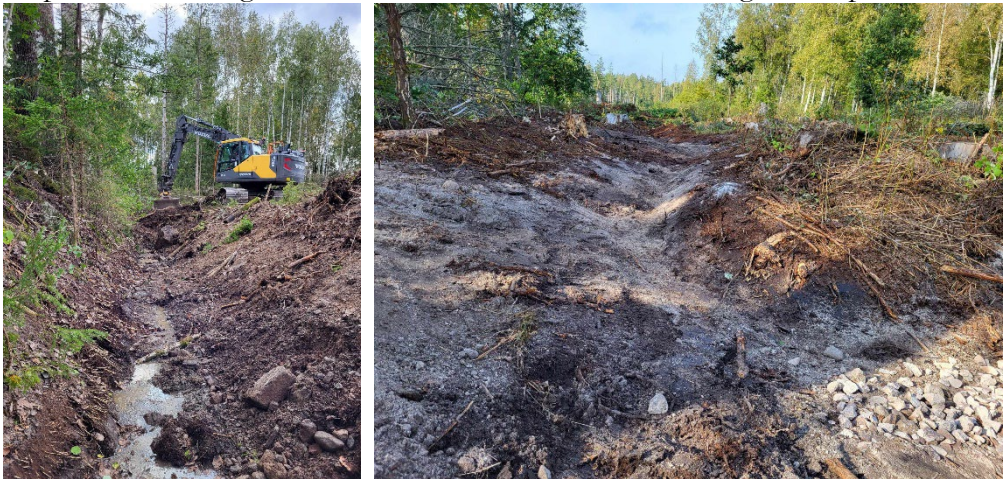
Figur 1: Till vänster: det grävda diket som anlagts för att dränera våtmarksmiljön läggs igen med grävmaskin. Till höger: Det gamla utloppet från våtmarken har skrapats fram och förväntas återaktiveras vid böga vattenflöden. Åtgärden återksapar en våtmarksmiljö på cirka 2 ha i Hornsö-Ekopark. Åtgärden är finansierad med medel från Naturvårdsverket.
