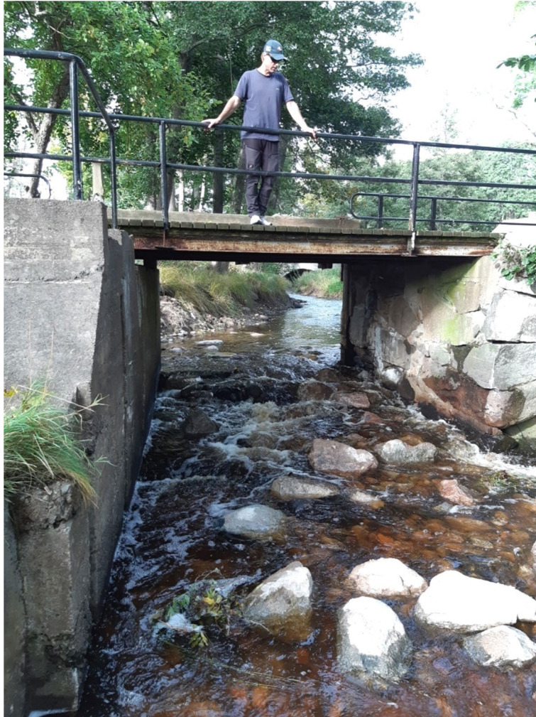
Figur 2: Åtgärdat vandringsbinder genom uppfyllning, Bubbetorps gård, Silletorpsån. Fundamenten har sparats för att bevara kulturmiljön. Foto: Andreas Skarmyr
